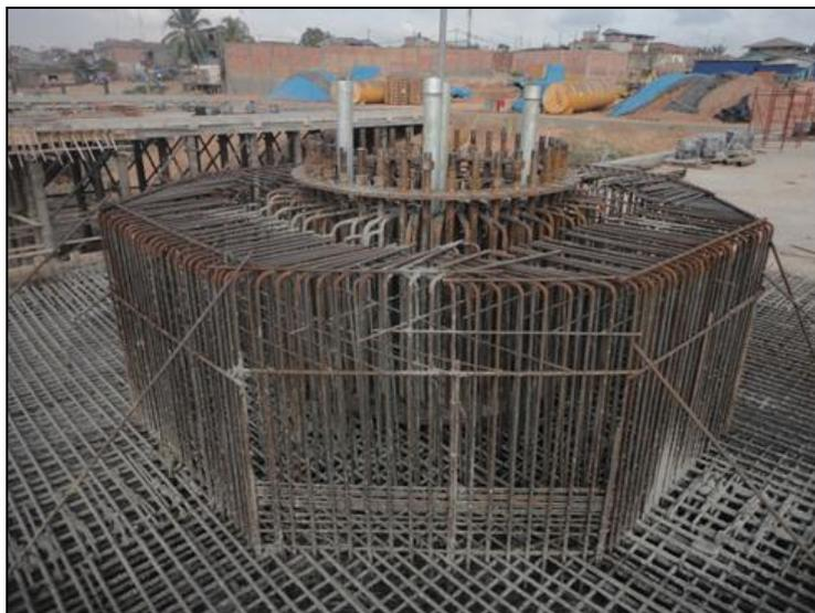
4. Estructura interna del bloque de anclaje de cada grúa de pedestal.
